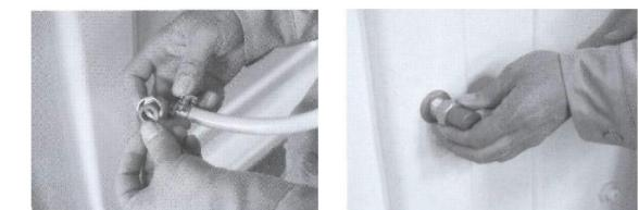
обязательно проверяйте прокладки в соединительных уголках
