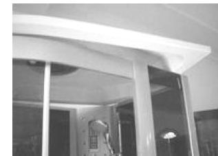
Поместите крышку наверх кабины. Болтами M5x20, плоскими шайбами диаметром 5 и гайками M5 закрепите крышку кабины поверх стенки. Плотно закрутите все болты, которые не были закручены.
