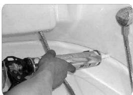
После того, как вы проверили и отрегулировали установленную кабину, нанесите санитарный силикон для уплотнения и герметизации в зазоры между стенкой кабины и нижним поддоном, стенкой кабины и верхней крышкой, стенкой кабины и боковыми стойками, направляющим рельсом и нижним поддоном, чтобы предотвратить утечку воды. Материал для уплотнения и герметизации необходимо наносить ровно и так, чтобы не пострадал внешний вид кабины.
