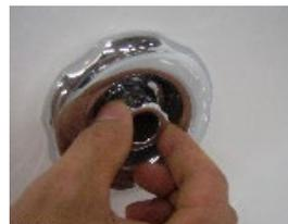
3. Очистки слива дренажа: выньте пробку и очистите сливное отверстие дренажной системы.
